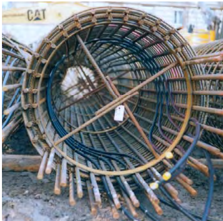
Energiepfahlherstellung
