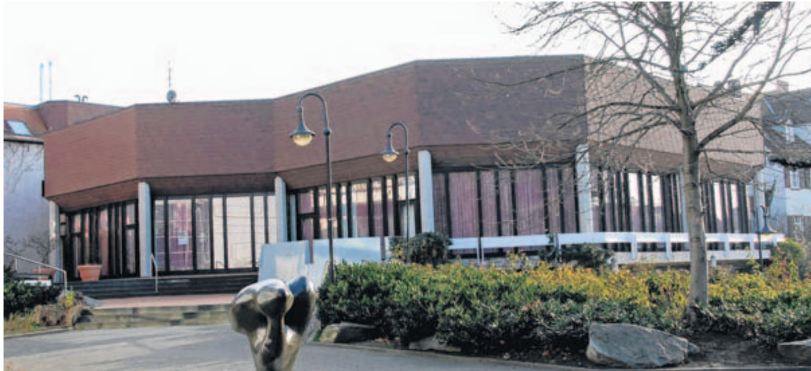
Der Zustand des Bürgerhauses war Diskussionsthema in der Stadtverordnetenversammlung. Das Gebäude muss saniert werden, möglich wäre aber auch der Abriss und ein Neubau auf dem Hoffart-Gelände. BILD: FUNCK
