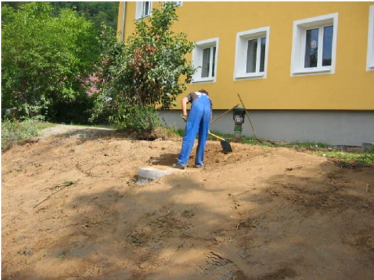
**Abbildung 4: Fertigstellung der Oberfläche nach dem Einbau der CO<sub>2</sub>-Sonden**
