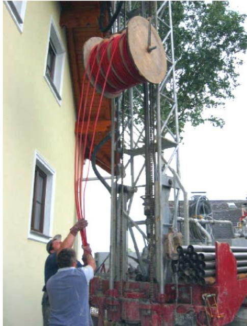
**Abbildung 3: Einbringung der CO<sub>2</sub>-Sonden in das vorbereitete Bohrloch**
